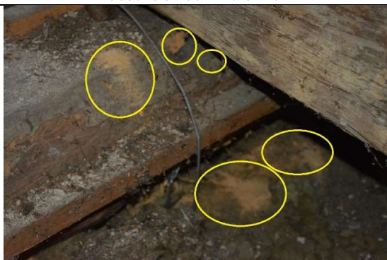
Fot. 31. Liczne otwory w drewnie i mączka drzewna – obecne szkodniki drewna
