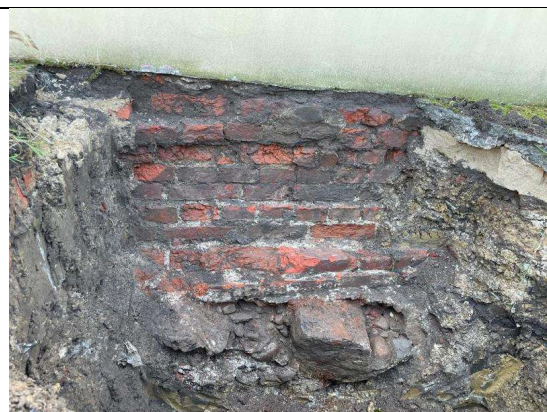
Fot. 3. Odkrywka fundamentu
