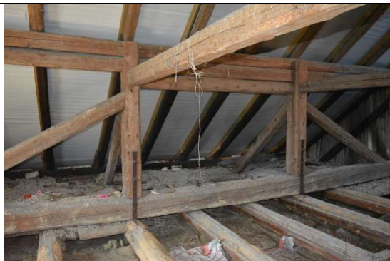
Fot. 27. Wieszar więzby dachowej nad salą konferencyjną – stan dobry.
