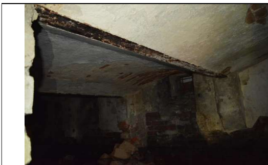
Fot. 42. Korozja dolnych półek belek stalowych stropu
