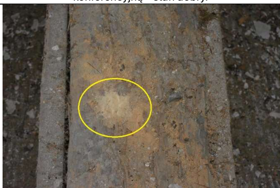
Fot. 29. Liczne otwory w drewnie i mączka drzewna – obecne szkodniki drewna
