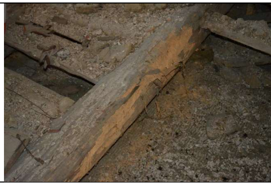
Fot. 32. Masowa korozja belek stropowych – zasięg względny
