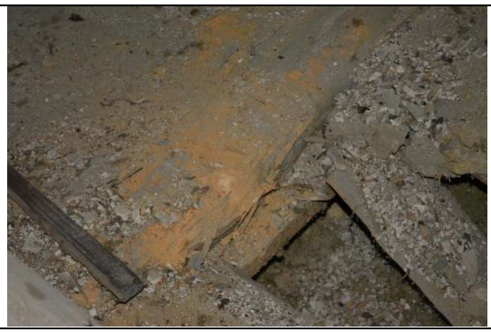
Fot. 33. Masowa korozja belek stropowych – zasięg względny
