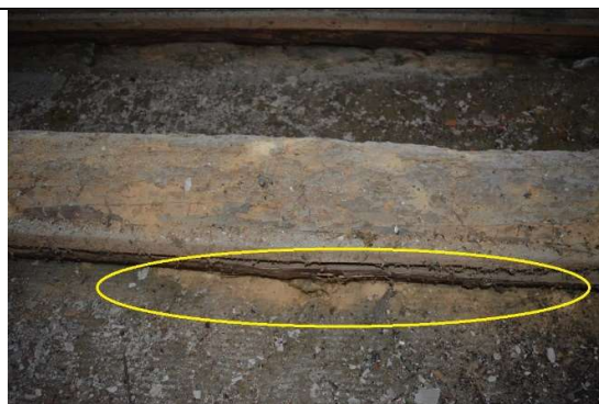
Fot. 28. Liczne otwory w drewnie i mączka drzewna – obecne szkodniki drewna
