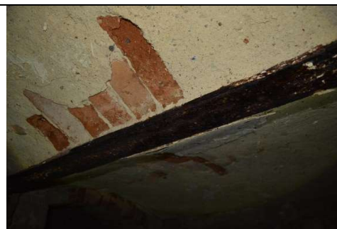
Fot. 43. Korozja dolnych półek belek stalowych stropu
